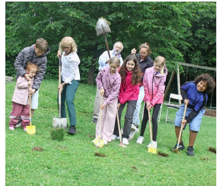
Gemeindepräsidentin Sandra Huber (3.v.l.) und Gemeinderat Edy Gilomen (hinten mit der Schaufel in der Luft) vollbringen mit Kindern und Familien den Spatenstich.
