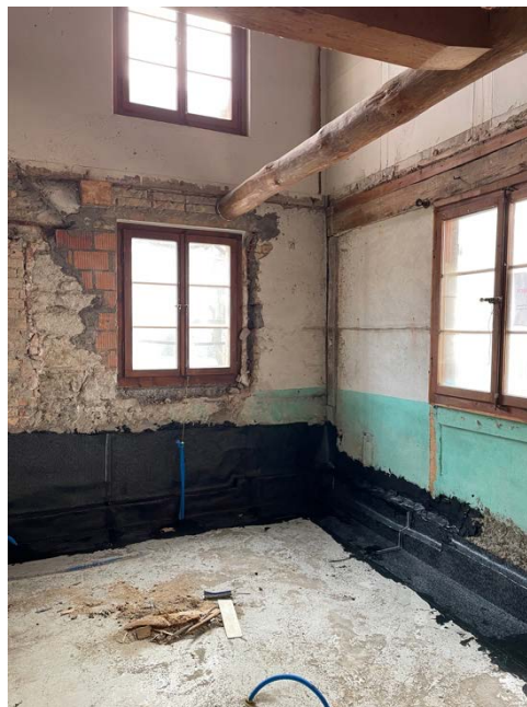
Remplacement de la poutraison Porcherie
