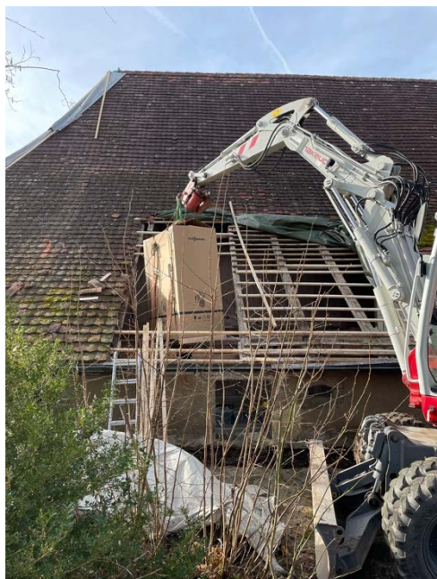
Introduction du nouveau chauffage dans l'ancien logement d'exploitation
