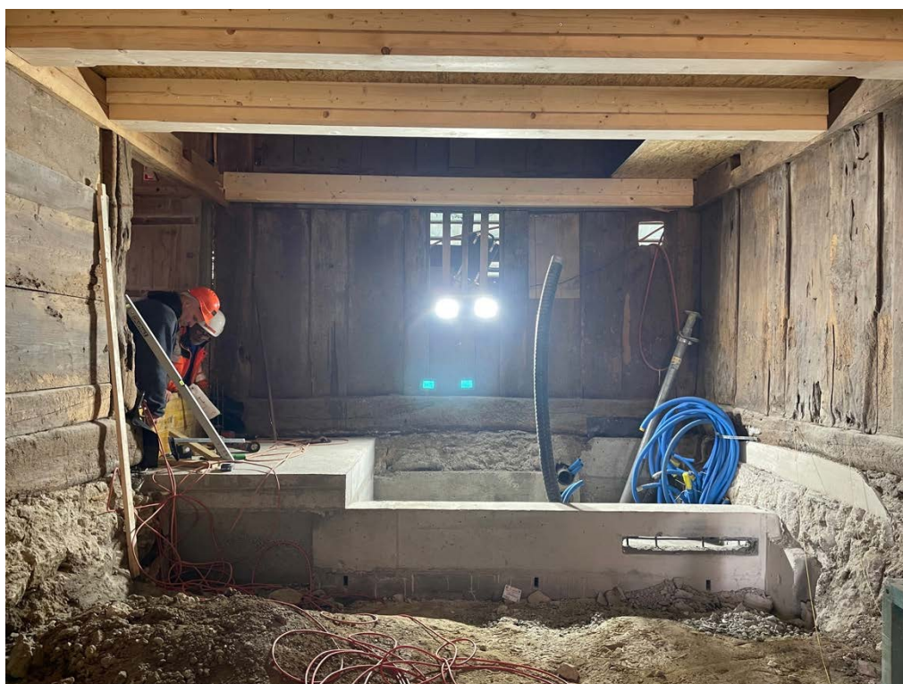
Nouvelle couche de poutres dans l'étable et palier d'escalier
