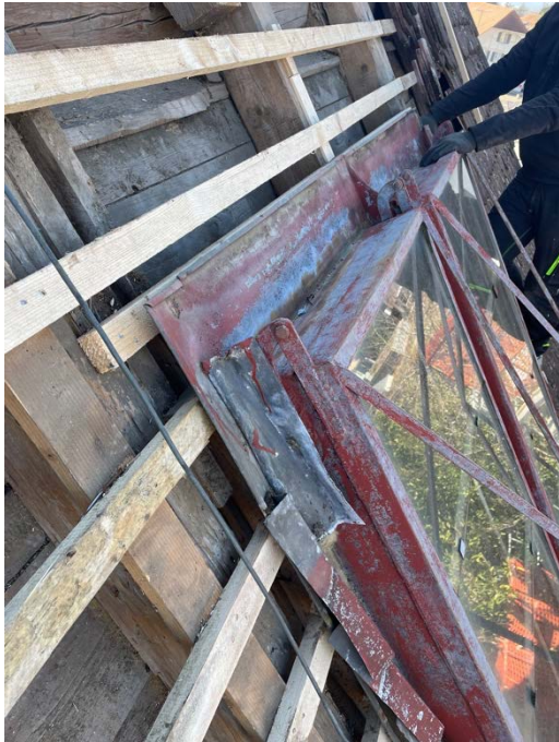
Historische Dachfenster des Ateliers mit Korrosionsschutz ergänzen
