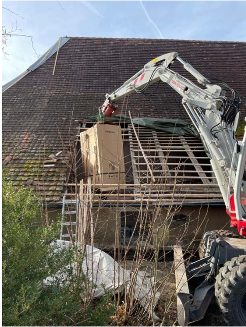
Einführen der neuen Heizung in den ehemaligen Schweinestall
