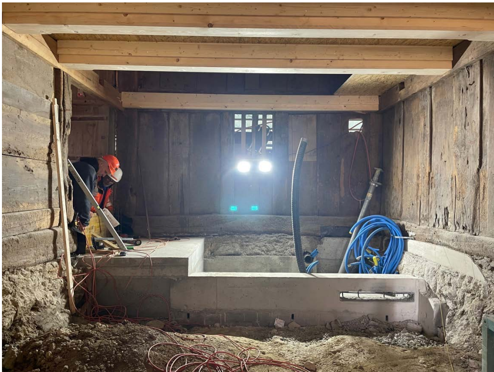
Neue Balkenlage im Stall und Treppenpodest
